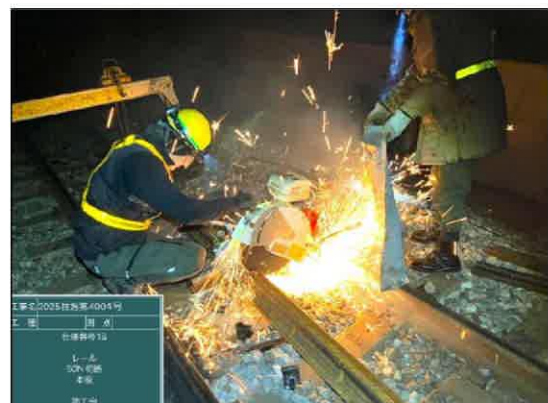
▲レールの交換工事
