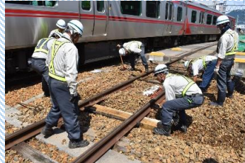
軌道構造の強化（マクラギ交換工事）
