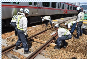
軌道構造の強化（マクラギ交換工事）
