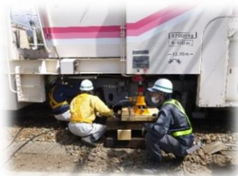
MTT脱線復旧訓練 （技術センター）
