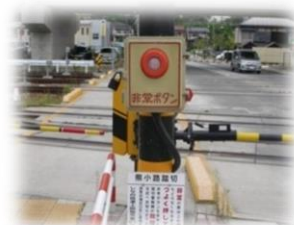
踏切支障報知装置
