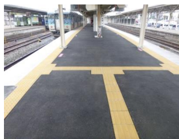
小諸駅乗降場改良工事
