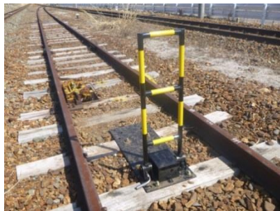
柵を立てて進出出来ない状態
