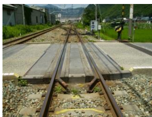
敷板ゴム化工事前
