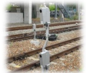
踏切障害物検知装置
