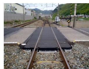
敷板ゴム化工事後
