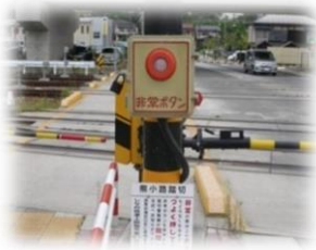
踏切支障報知装置 (非常ボタン)
