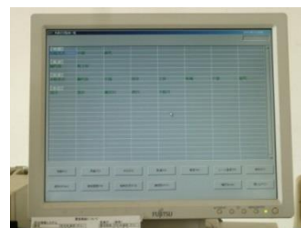
指令室防災情報システム (表示装置)
